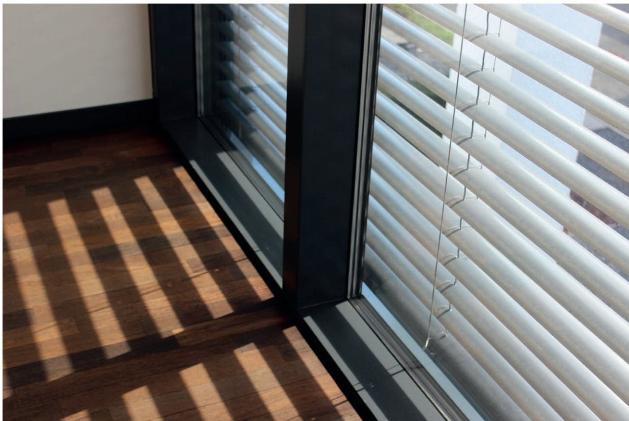
Abb.42 - Elektrische Lamellenjalousien lassen noch Licht herein, die Sonnenenergie bleibt bei entsprechender Lamellenstellung aber draußen
