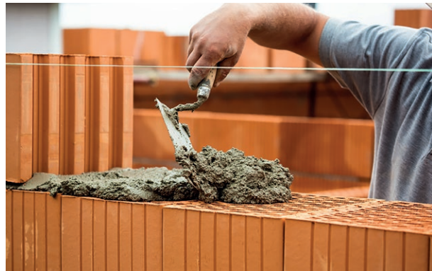
Abb.38 - Massive Wände aus Hochlochziegeln sind ressourceneffizienter als Kalksantstein oder Vollziegel
