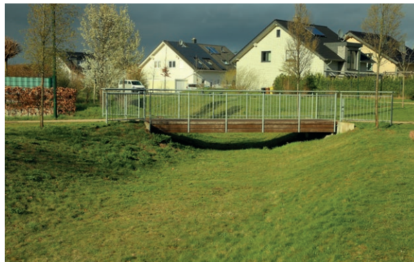
Abb. 11 - In diesem Wohngebiet wurde die Regenwasserentwässerung ressourcenschonend mitgedacht. Nach einem starken Regenereignis führt diese Brücke über die versickernde Wasserfläche. Die Regenwasserrückhaltung ist somit in die Grünanlagen der Siedlung integriert.
