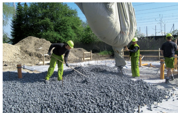
Abb.34 - Schaumglasschotter oder Recyclingschotter sind ressourceneffiziente Alternativen zu normalem Kies
