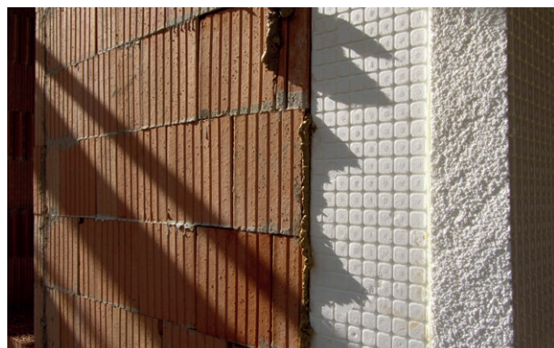
Abb.41 - Ein WDVS ist aus Ressourcensicht ein ungünstiges Fassadenmaterial
