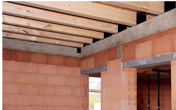
Abb. 16 - Holzbalkendecke im Massivbau
