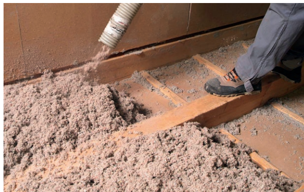
Abb.39 - Geschosdeckendämmung mit Zelluloseflocken
