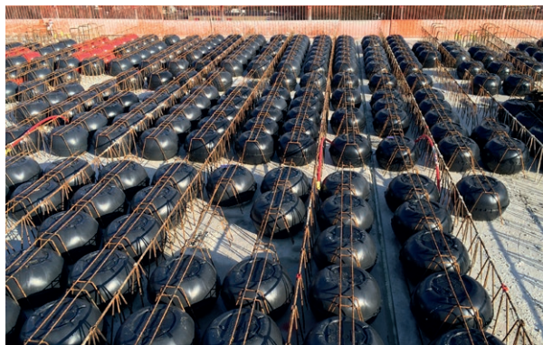
Abb. 14 - Bewehrung mit Kunststoff Hohlkörpern
