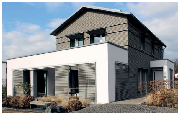
Abb. 15 - Einfamilienhaus in Holzbauweise
