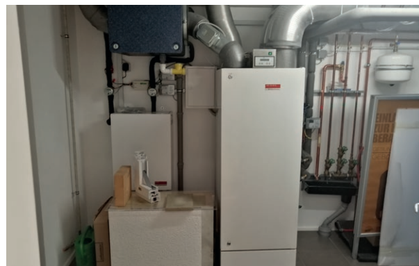
Abb.33 - Der Hausanschlussraum kann auch als Abstellkammer dienen
