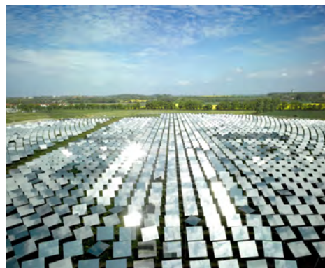
Blick vom Solarturm Jülich
