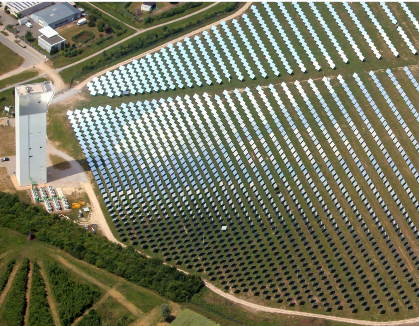
Der Solarturm Jülich ist eine Testanlage für kommerzielle Turm- kraftwerke. Betrieben wird er vom DLR-Institut für Solarforschung.
