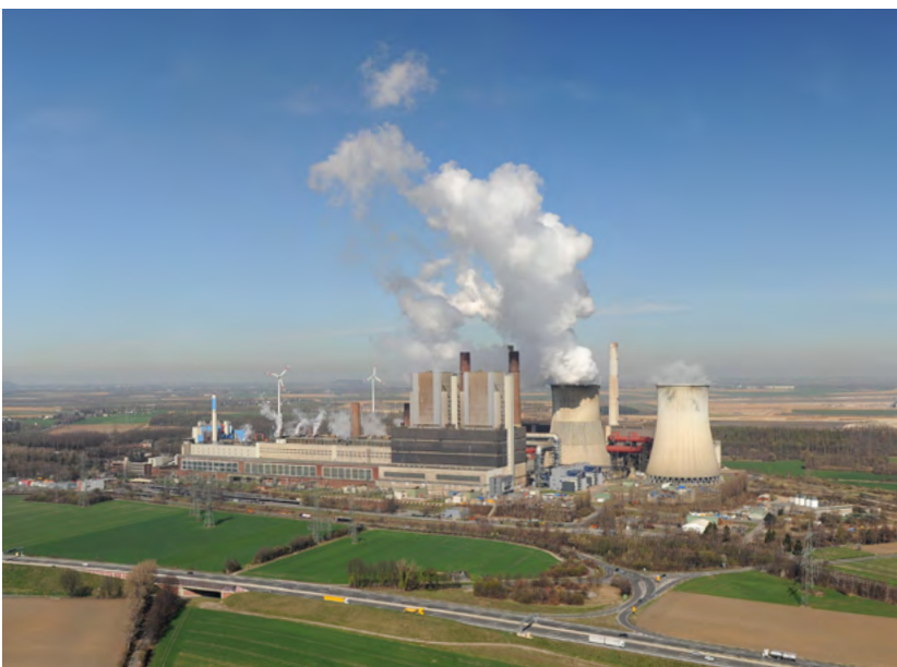
Kraftwerk Weisweiler der RWE Power AG in Eschweiler-Weisweiler
